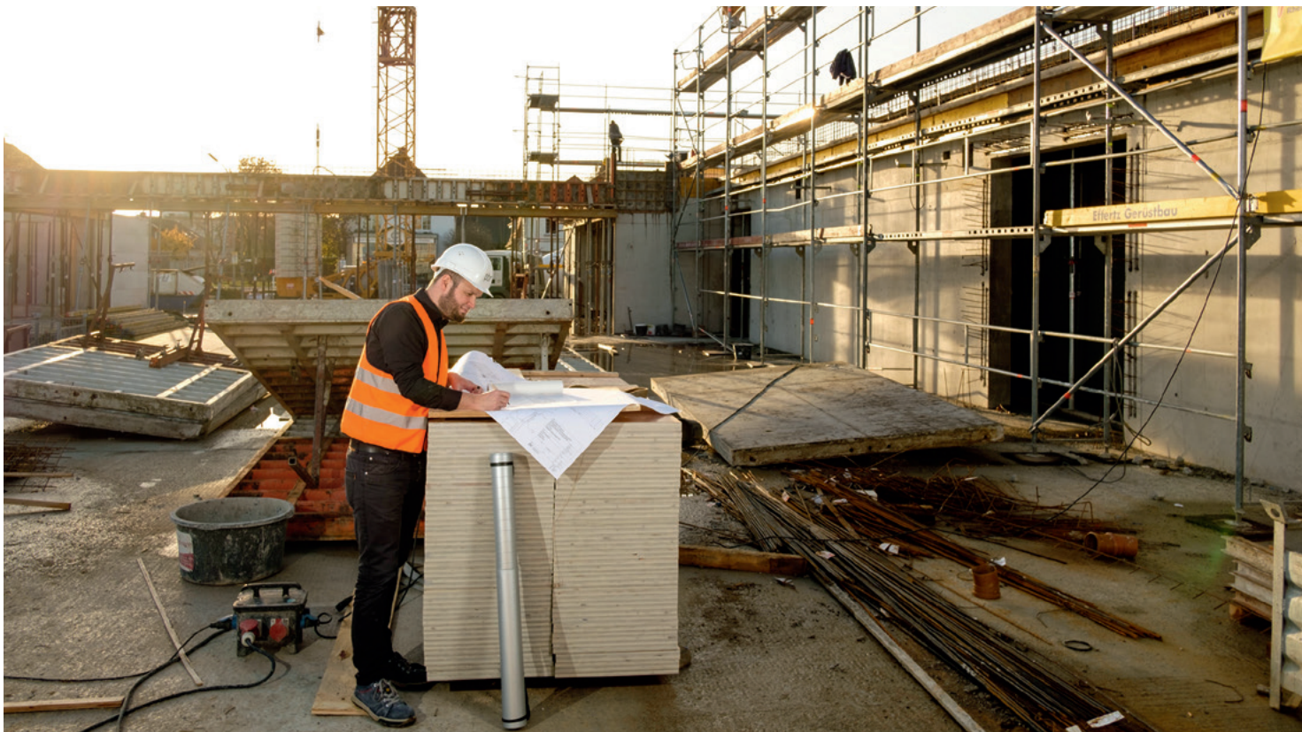
Die tiefstehende Novembersonne wärmt die Baustelle ungewohnt. Gut für den Baufortschritt.
