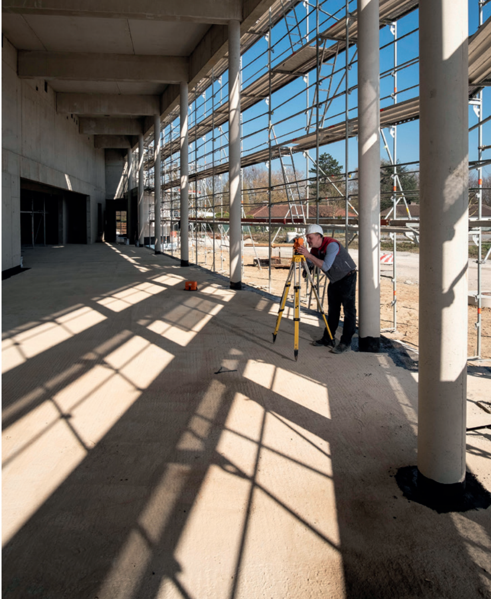
Wenn es auf jeden Zentimeter ankommt: Polier Armin Barthel kontrolliert die Abmessungen der neuen Stadthalle.
