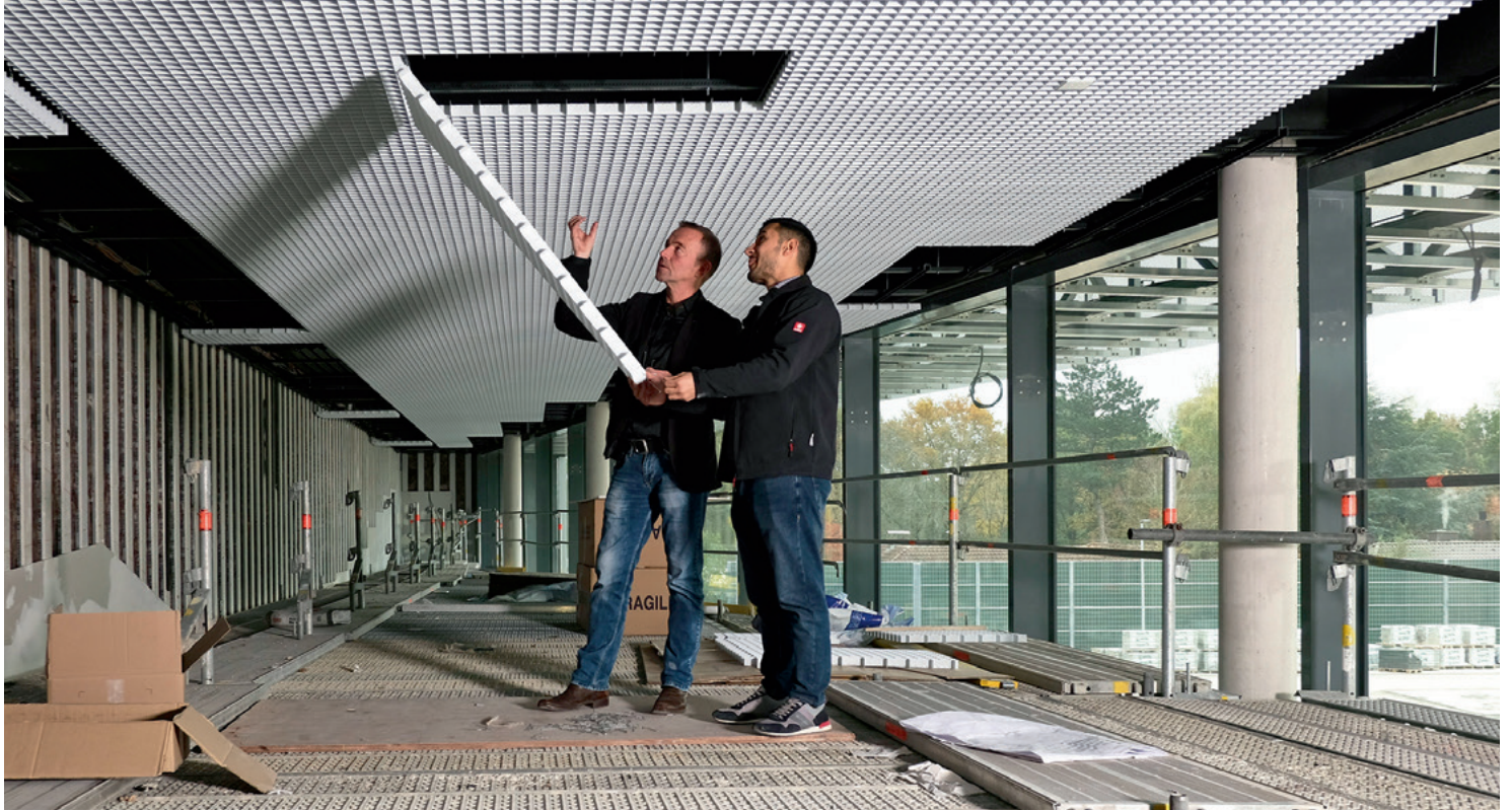
Dem Himmel ganz nah: in sechs Meter Höhe erörtern Burkhard Okel und Giorgi Tamoian Details der Konstruktion für die Rasterdecke im Foyer der Stadthalle.
