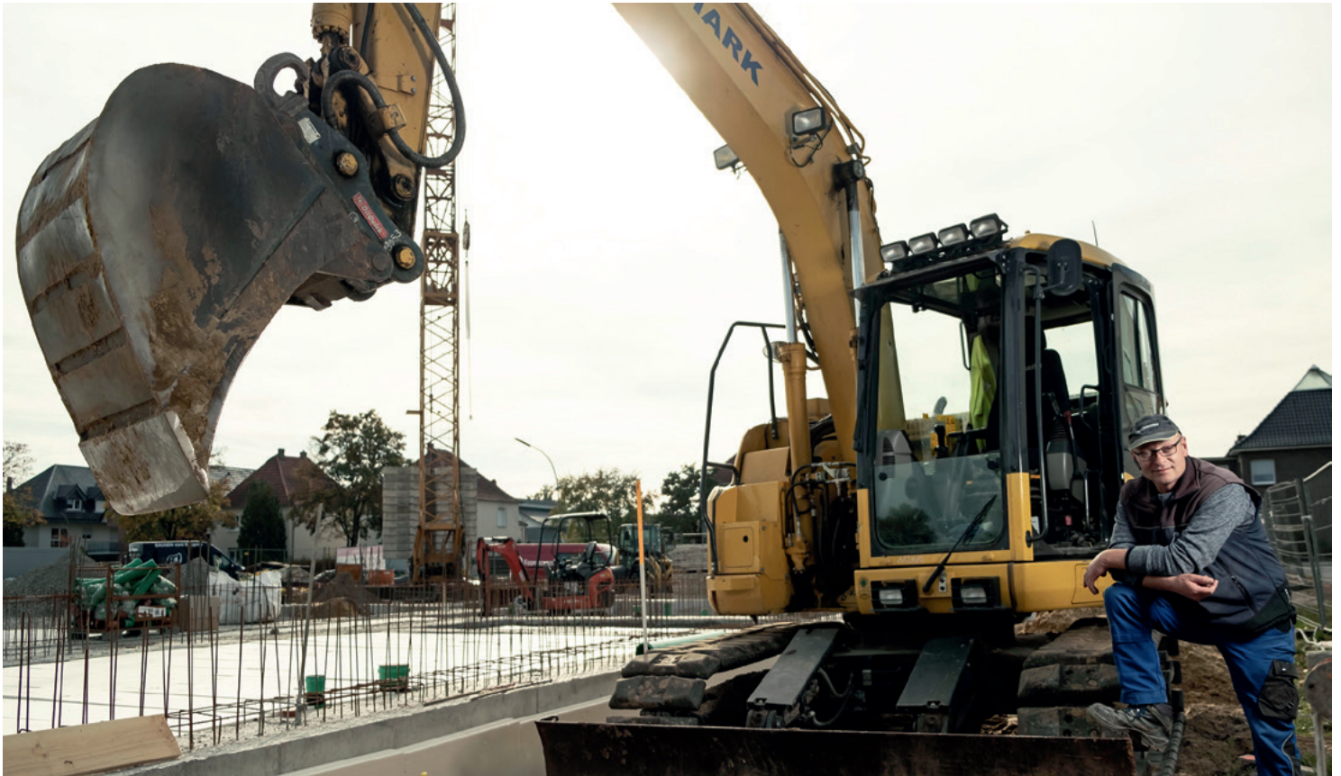
Paul Helftwes und sein »Löffel« – kantig konstruiert für das präzise Ausheben von Kanälen.
