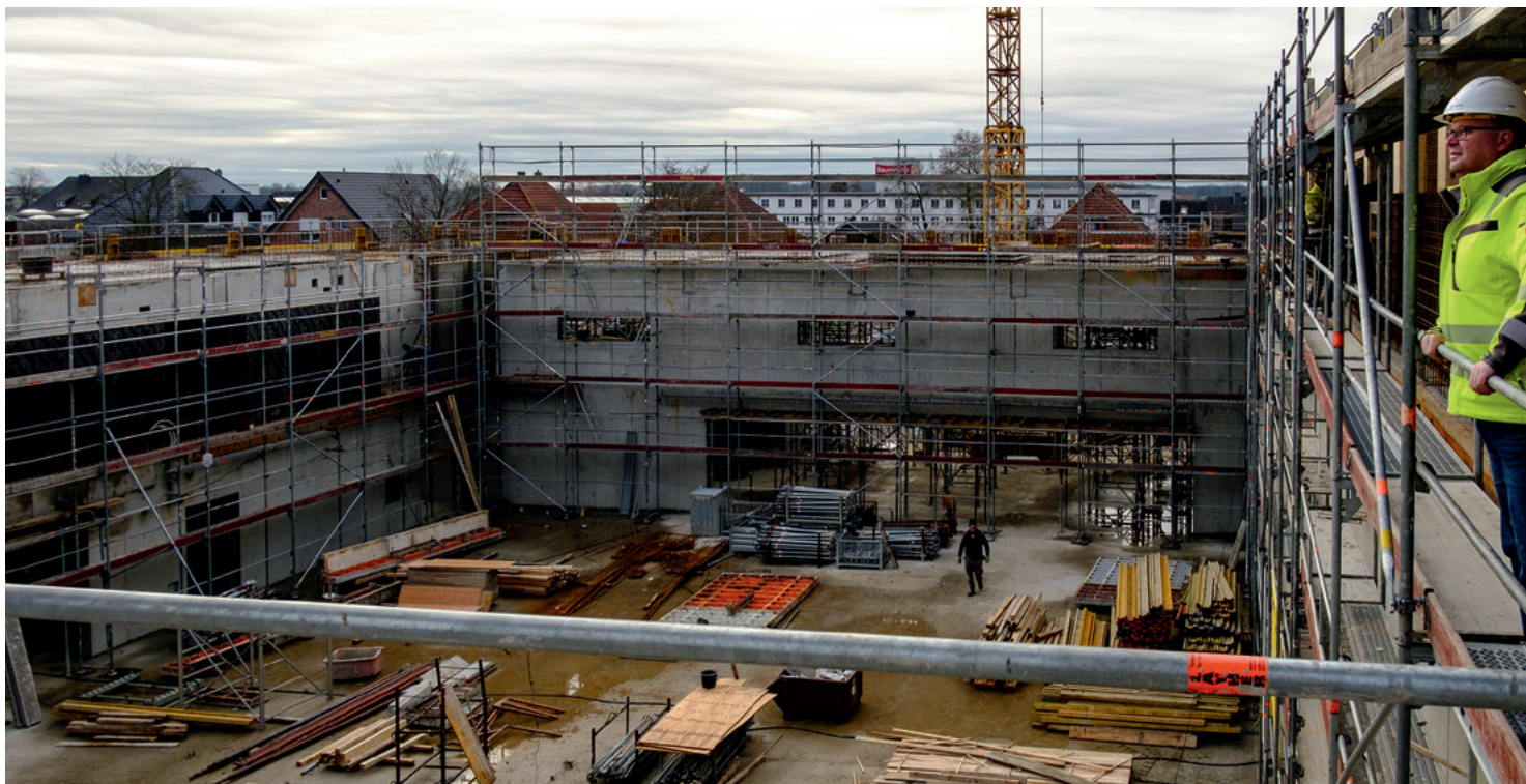
Hier werden demnächst Stahlbetonbinder 25 Meter weit den Saal überspannen. Statiker Reinhold Kuhle hat dabei immer das wirtschaftlich und konstruktiv Machbare im Blick.
