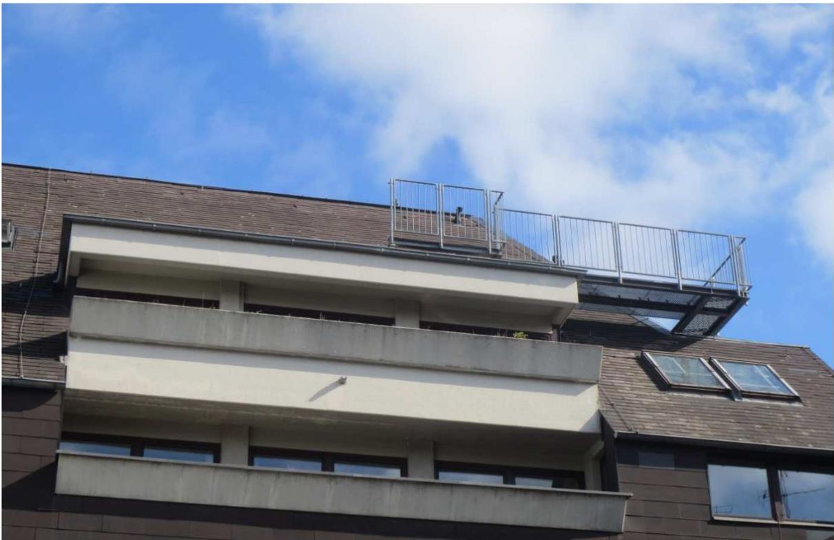
Foto 6: Selbststrettungsweg aus rückwärtiger Nutzungseinheit mit Wartebereich (DIN 14094-Teil2)
