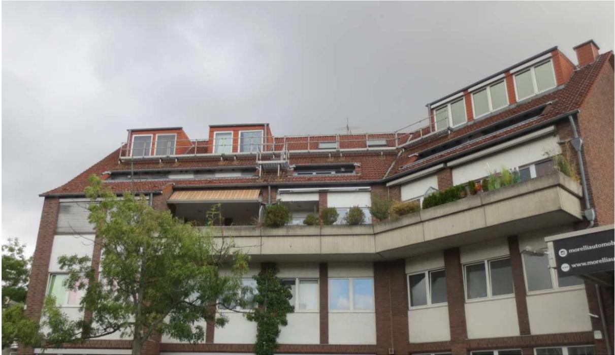
Foto 5: Selbststrettungsweg mit Anschluss an mehrere Nutzungseinheiten (Laufsteg) und Wartepodest (DIN 14094-Teil2)
