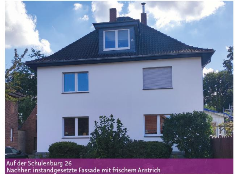
Auf der Schulenburg 26 Vorher: witterungsbedingte Verunreinigungen sowie Schäden an der Putzfassade
