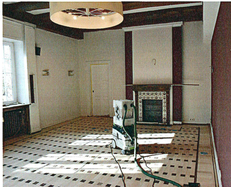
Erdgeschoss, ehem. Wohnzimmer, heute Gastzimmer
