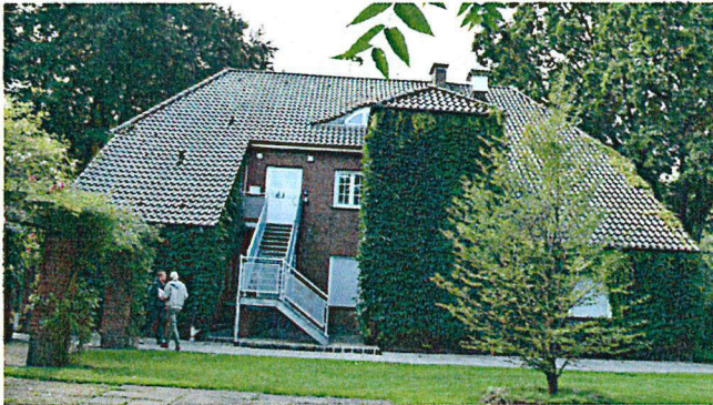
Nordansicht mit nachträglichem, turmartigen Anbau
