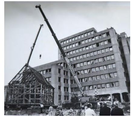
Rathausneubau und versetztes Fachwerkhaus
