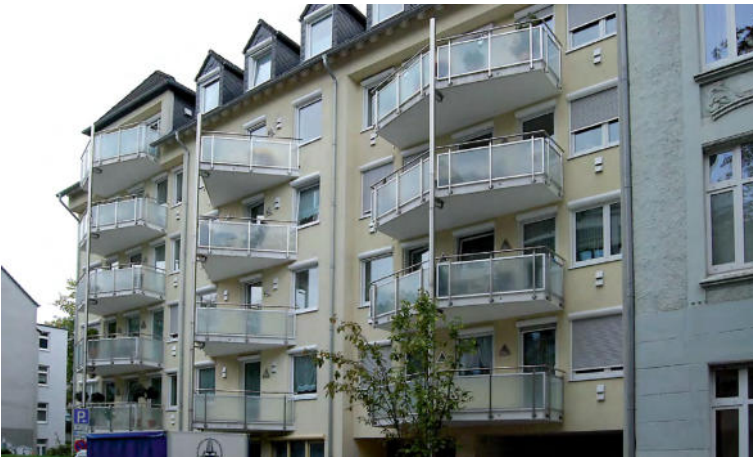
✗ Überdimensionierte Balkone (Herne)
