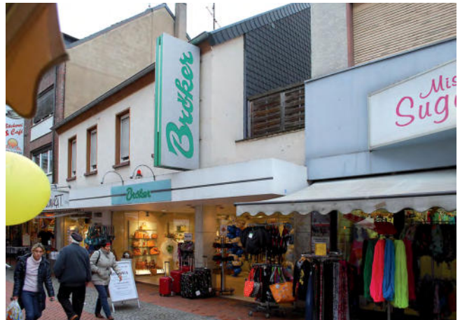
✗ Verspringende Kragplatten (Herne)
