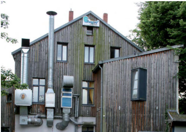
Großformatige Lüftungsanlagen (Essen)
