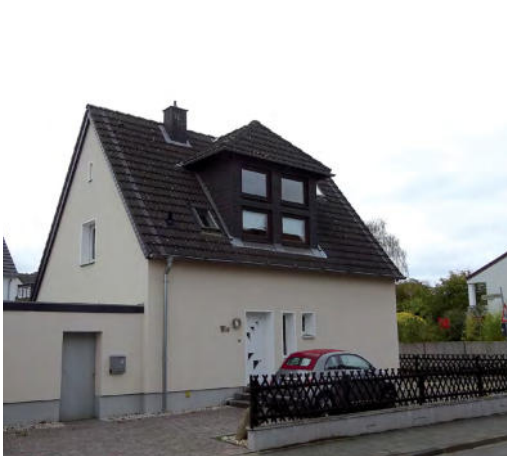
✗ Überdimensionierte Dachgaube (Kreuzau) und (Dülmen)
