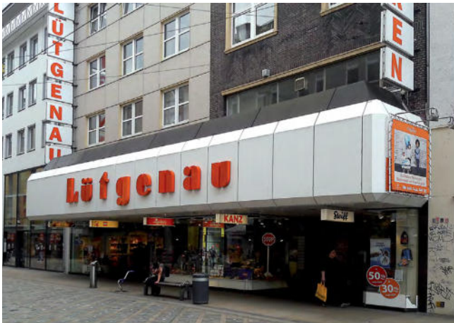
✗ Überdimensionierte Kragplatte (Dortmund)
