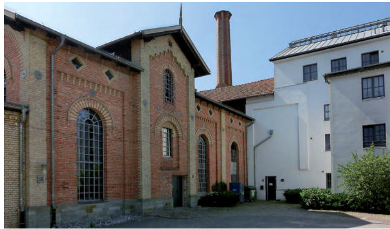
Ehemalige Brennerei Hagedorn
