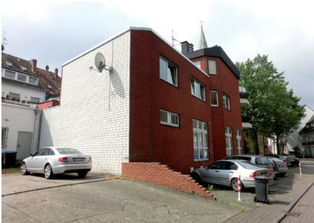
✗ Ungestaltete Stellplatzanlage (Dorsten)
