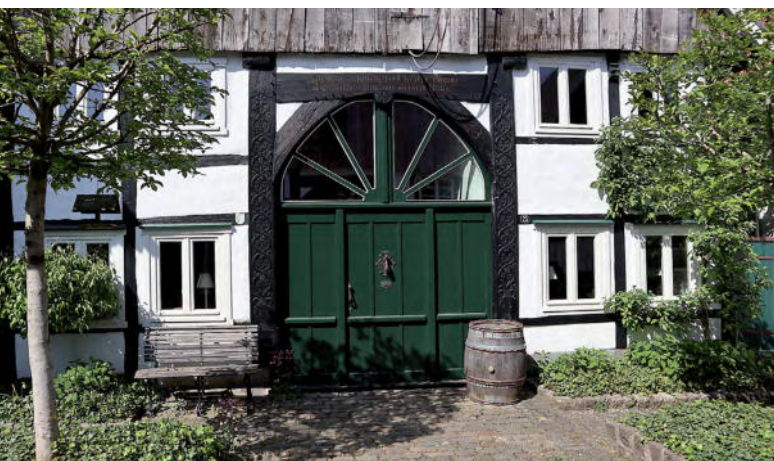
Renoviertes Gebäude (Großer Wall)
