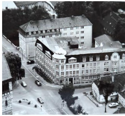
Rawe-Gebäude (Gütersloher Str./Berliner Str.)
