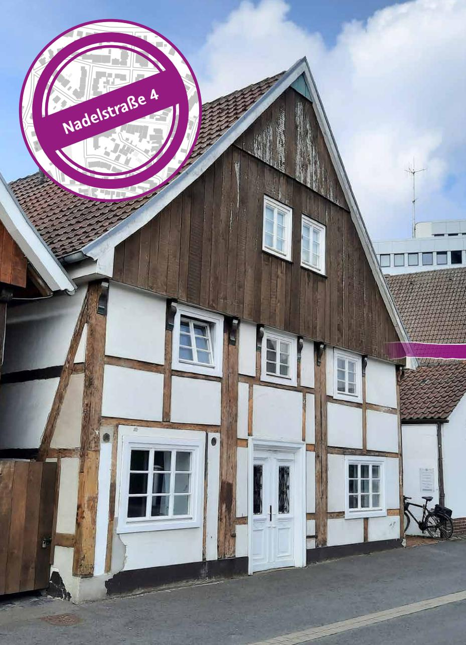
Vorher: Witterungsbedingte Verunreinigungen sowie Schäden an der Fachwerkfassade und dem Giebel.
