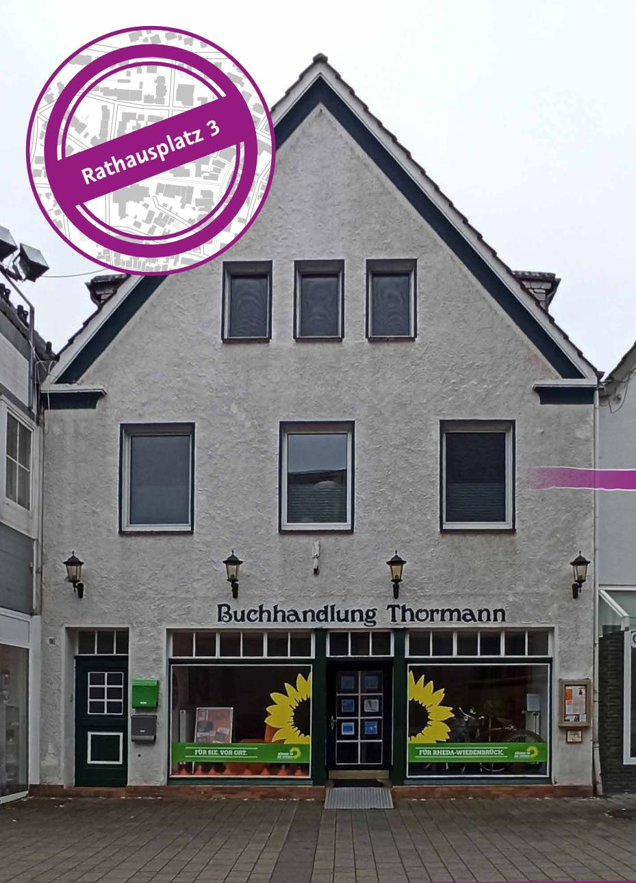
Vorher: Witterungsbedingte Verunreinigungen an der Fassade sowie Farbabplatzungen an den Fensterrahmen im Erdgeschoss.
