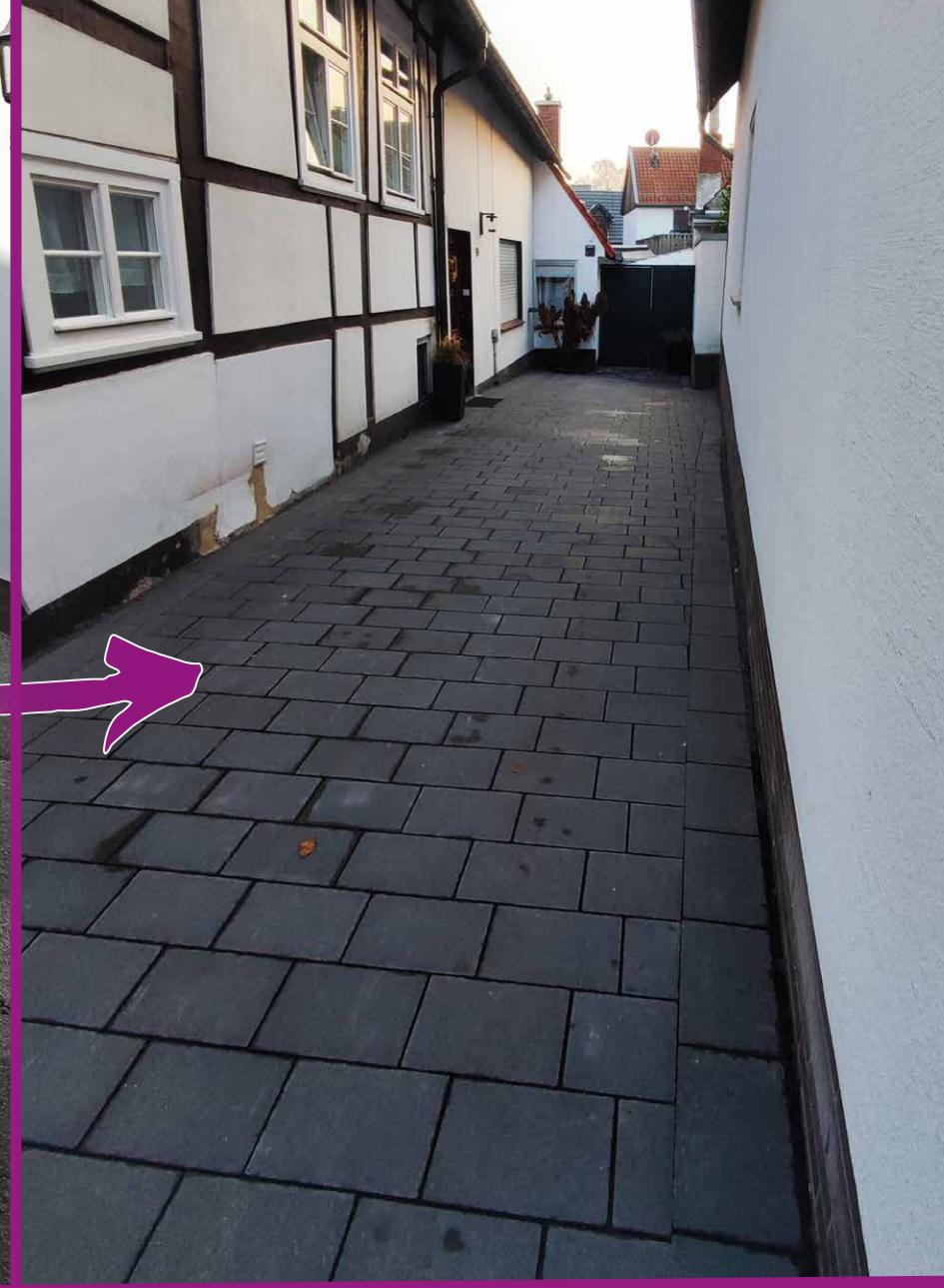
Nachher: Das verwendete DSK Enviro Öko Pflaster bietet die Möglichkeit, dass das Regenwasser an Ort und Stelle versickern kann.
