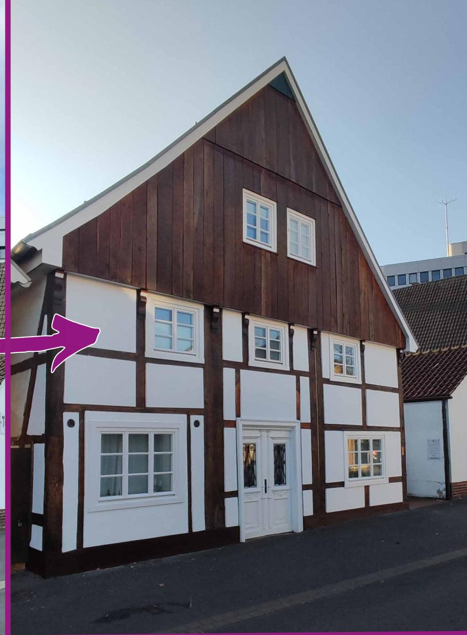
Nachher: Frischer Anstrich der Gefache sowie farblich abgesetzter Sockel. Fachwerkbalken und Giebel wurden neu lasiert.
