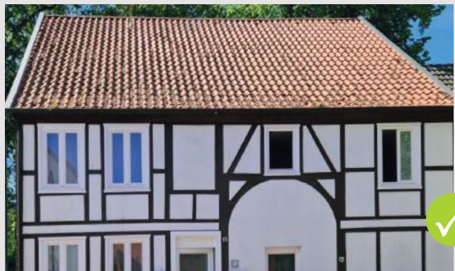
Ortstypische Dachlandschaft mit naturroten Dachziegeln
