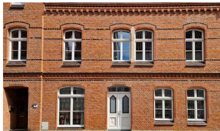
Beispiel einer Ziegelfassade im Stil des Historismus
