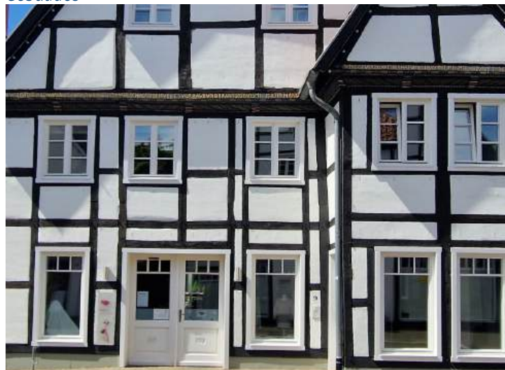
Positivbeispiel von kleinteiligen Schaufenstern in einer Flucht mit Fenstern der Obergeschosse
