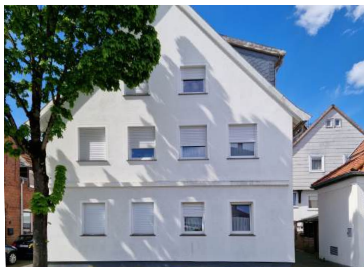
Positivbeispiel einer hellen Putzfassade
