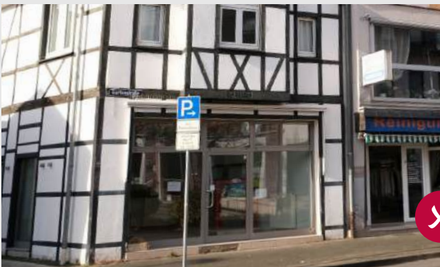
Großformatige Schaufenster fügen sich nicht in Fassadengestaltung ein
