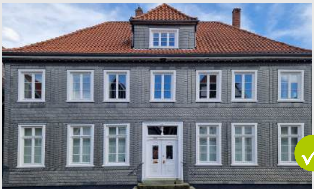
Ortstypische, kleinteilige und aufeinander ausgerichtete Fenster
