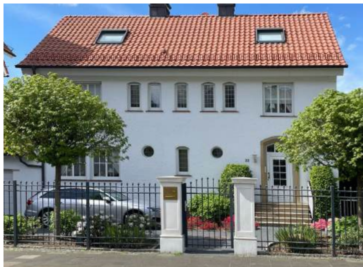
Positivbeispiel einer Einfriedung aus schmiedeeisernem Gitter
