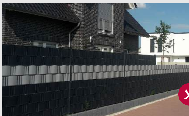
Stabmattenzaun mit Kunststoffeinfriedung
