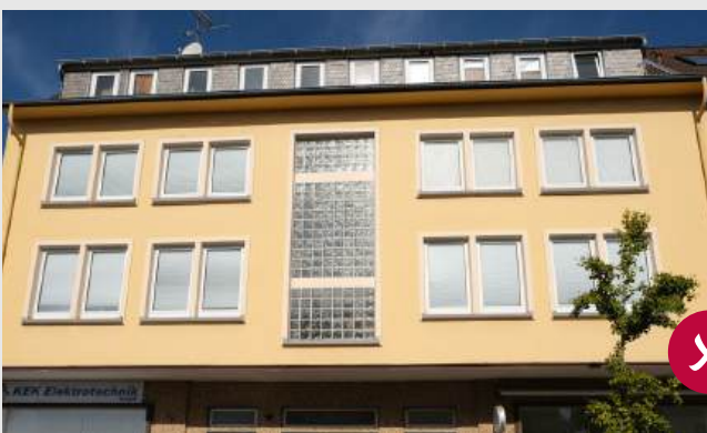
dominierende Dachaufbauten beeinflussen die Dachlandschaft negativ
