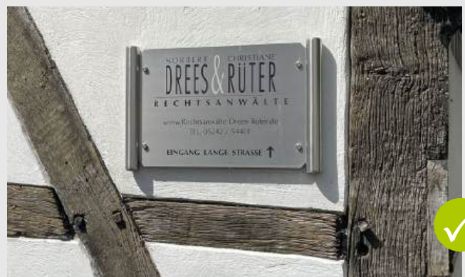
Hinweisschild ist in Gefache der Fassadengestaltung integriert
