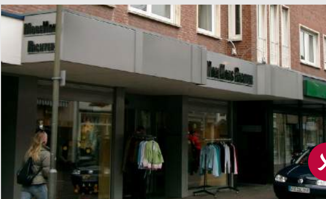
Durchlaufendes Vordach führt zu trennender Wirkung von Erdgeschoss und Obergeschossen
