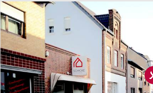
Unpassender Höhenversprung in der Straßenrandbebauung
