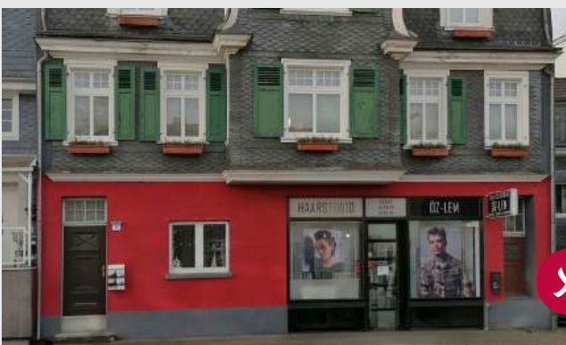
kein Bezug zwischen Fensteröffnungen des Erdgeschosses und Obergeschossen führt zu getrennter Wirkung
