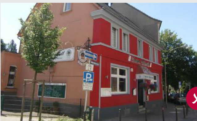
Signalrot gestrichene Fassade fügt sich nicht in die restliche Gebäudegestaltung ein und prägt das Stadtbild negativ
