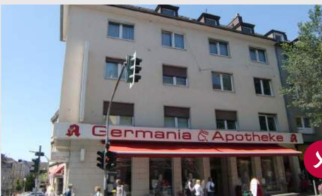
Horizontale Werbeanlage mit Trägerplatte über die gesamte Fassadenlänge
