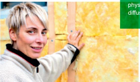
Immer wieder wird erzählt, gedämmte Bauteile würden das „Atmen“ der Wände verhindern. Bauphysikalisch ist das Unsinn. Luftdicht und dampfdiffusionsoffen – das geht beides zugleich.
